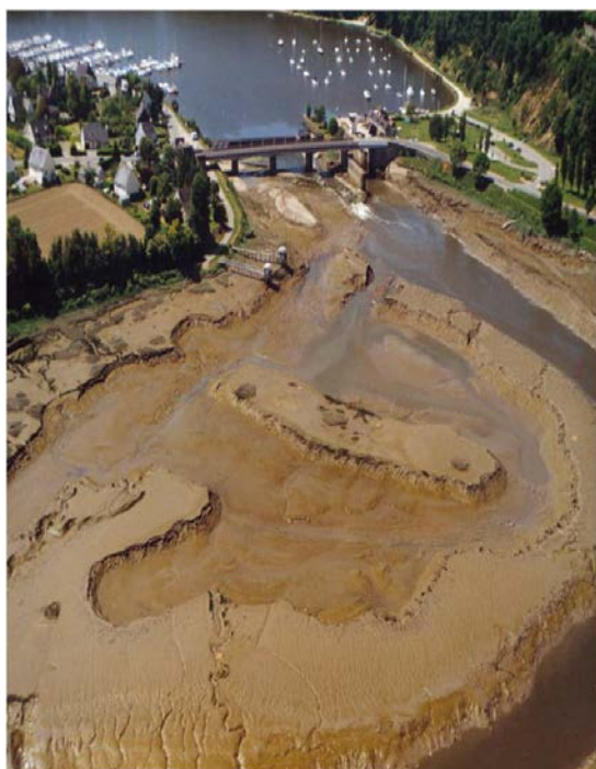
Figure 2: Vue aérienne du piège à sédiments de Lyvet après sa création en 2001
